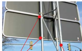
Alform-Klemmschelle Dreiecksgittermast AKS 60
