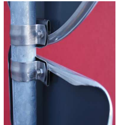
Aluminiumblech mit umgebördeltem Rand
