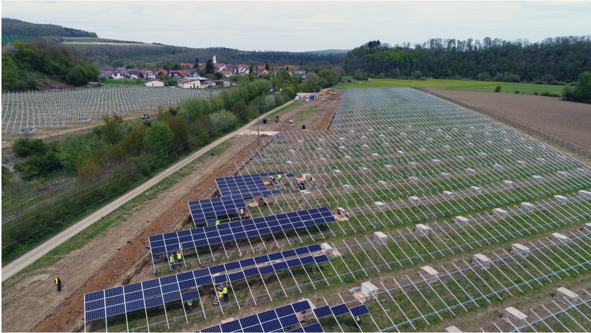
Bildunterschrift: sun.factory baut PV-Freiflächenanlage mit 5,2 MW für ENBW. Foto: sun.factory
