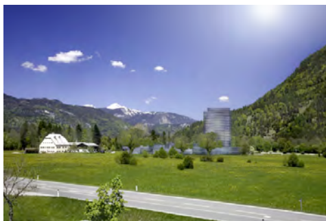
Im Frühjahr 2011 wird in St. Martin bei Lofer mit dem Bau des „Saalach Resort – Home of Balance“, dem neuen Leitbetrieb des Pinzgauer Saalachtals, begonnen.
