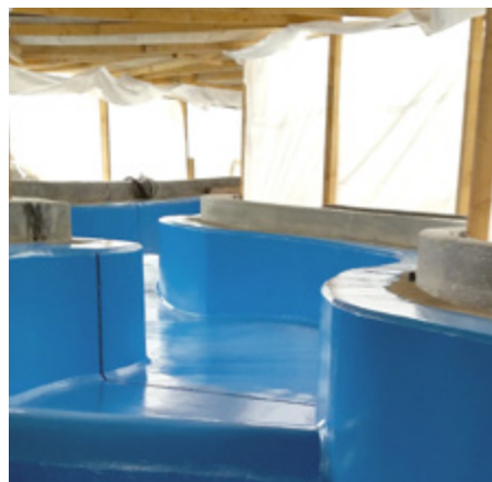
Nach der Grundierung wurde Fläche angeschliffen und das Beschichtungsprodukt PROGUARD CN 200 aufgetragen
